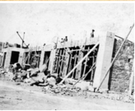
Año 1934. Construcción de escuelas.
