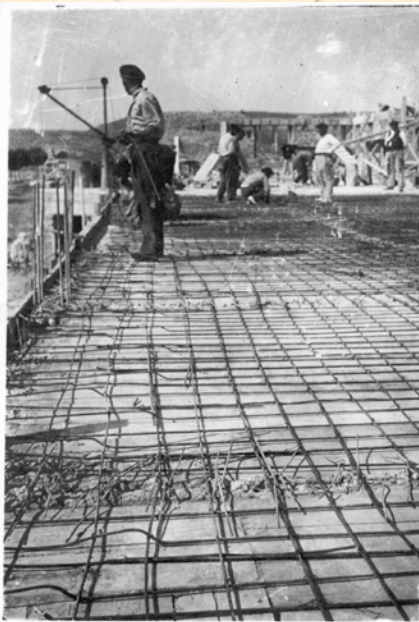
Año 1934. Construcción Escuelas.
