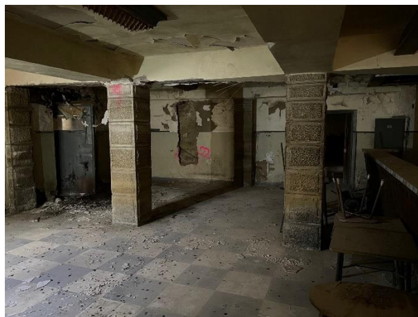
Elementos estructurales hormigón armado en planta baja.
