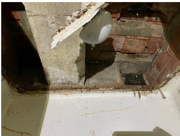
Elementos estructurales de hormigón armado en planta superior.
